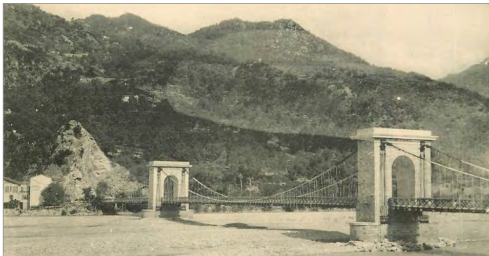
Il ponte “Carlo Alberto”, poco a monte di Saint Martin du Var, demolito nel 1912 e poi ricostruito (ved. nota 89)
