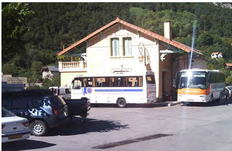
La vecchia stazione della tranvia, oggi utilizzata ovviamente come capolinea degli autobus.
